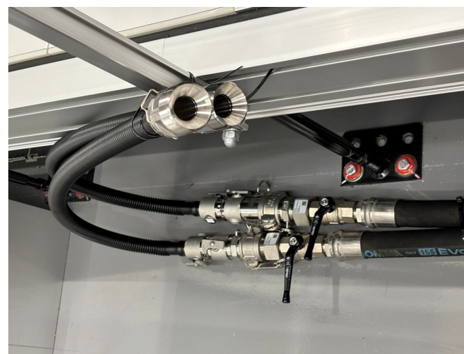
水冷配管接続部
