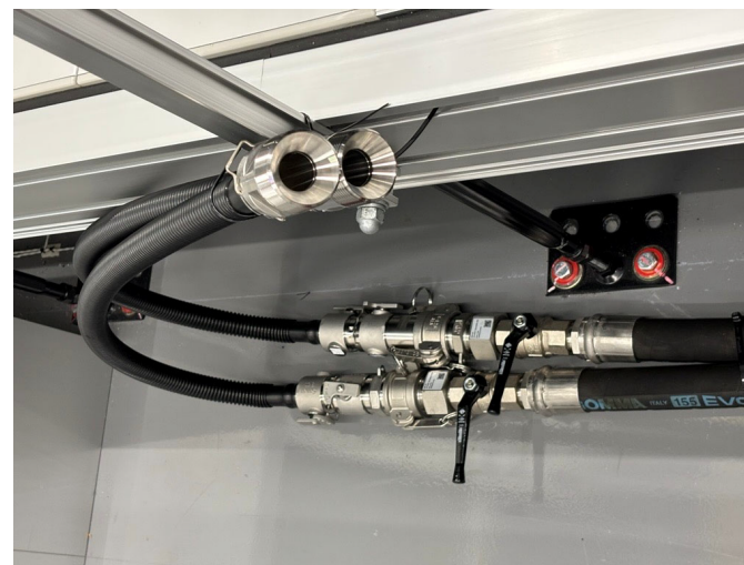
水冷配管接続部
